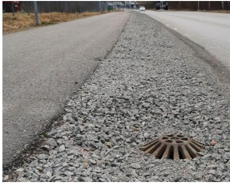
Figur 14. Till vänster. Foto på krossdike med bräddfunktion mellan GC-bana och väg. Plats: Alängsgatan, Ulricehamn. Till höger: Schematisk bild av ett makadamdike/krossdike. Bildkälla: Stockholm stad, 2025.
