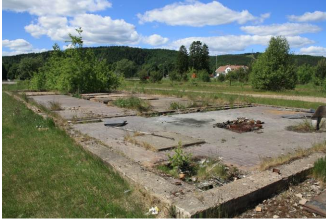
Figur 8. Fundament från växthusverksamheten.
