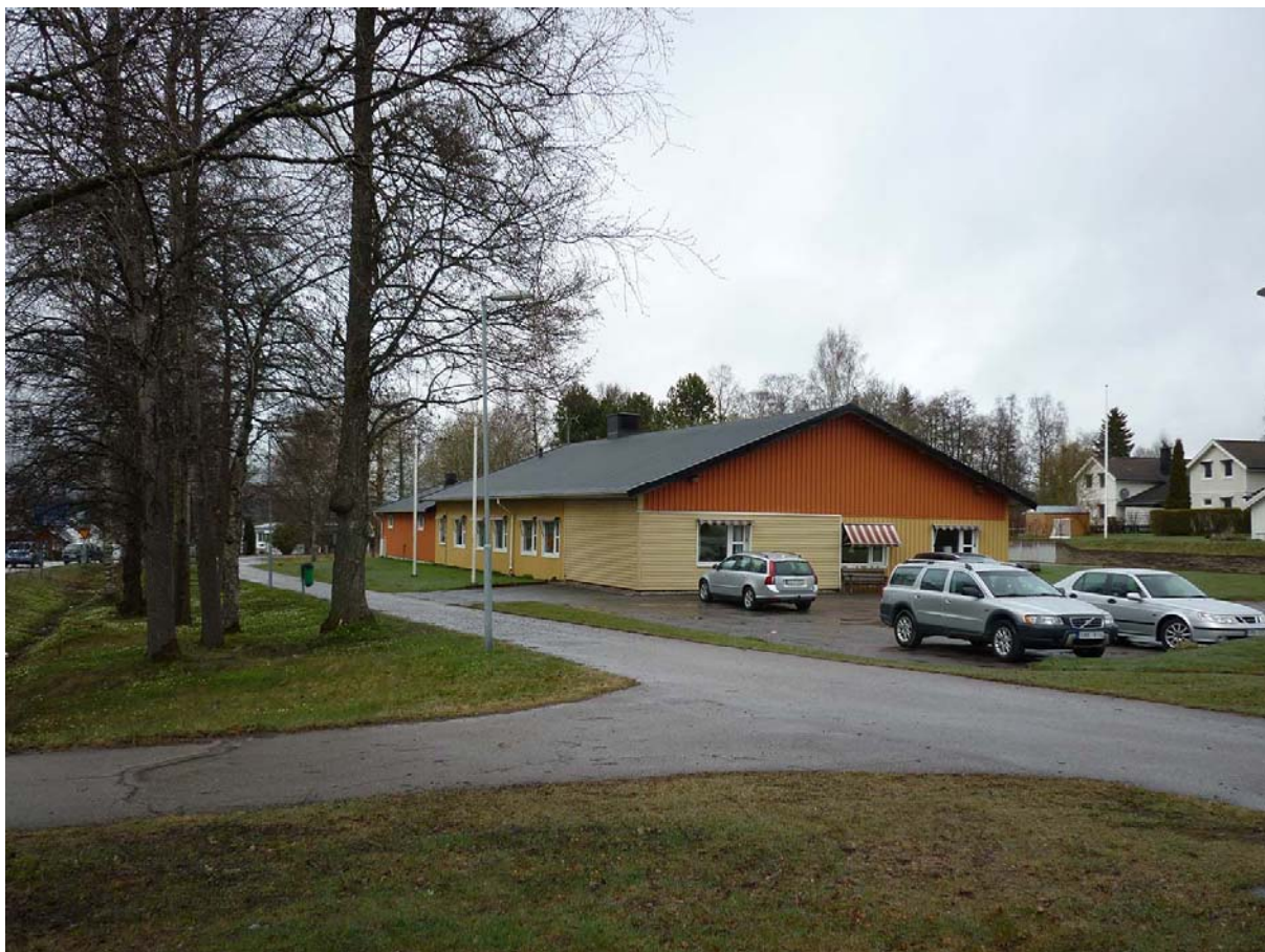
Vy från korsningen Grönhögsvägen Fällornavägen in mot Apeln 1. Foto MSB
