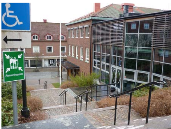
Bild 3. Fastighetens södra fasad.
