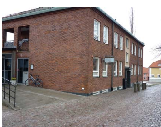
Bild 4. Fastighetens västra fasad som vetter mot Västra Kyrkogatan.
