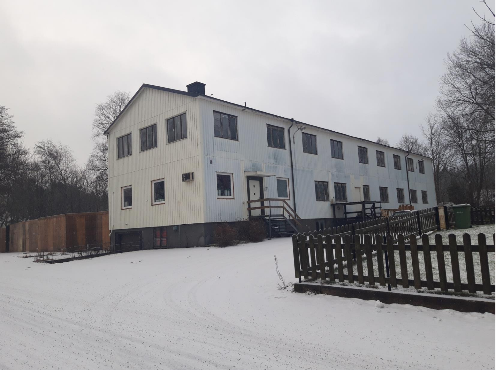
Fabriksbyggnaden, foto: My Andreasson
