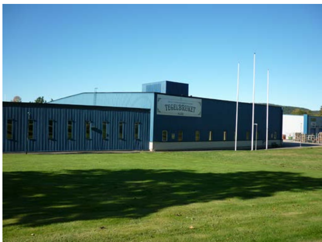
INDUSTRIBYGGNAD INOM KV. DALTORP
