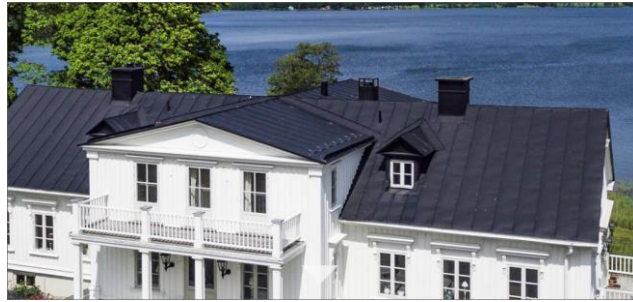
Ollestad 5:11 byggnad från 2006. Från prospekt.
