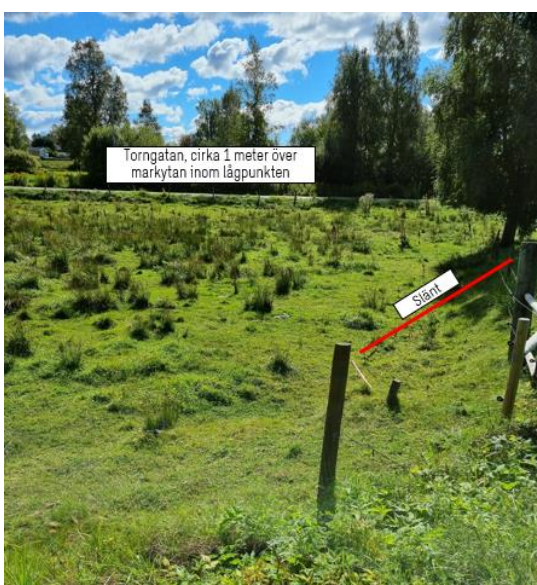
Figur 7 Lågpunkt mellan GC-bana och Torngatan.
