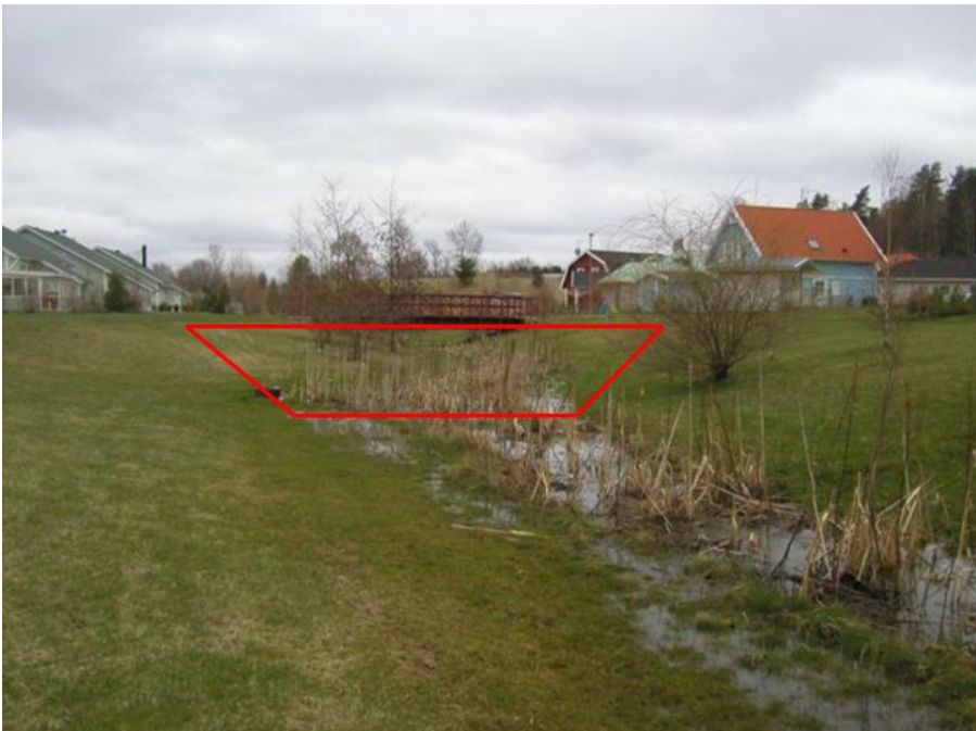
Figur 11 Exempel på hur slänter runt diket kan omformas för att skapa större fördröjningsvolym som kompensation om delar av volymen inom lågpunkten byggs bort genom uppfyllnad för att möjliggöra bebyggelse.
