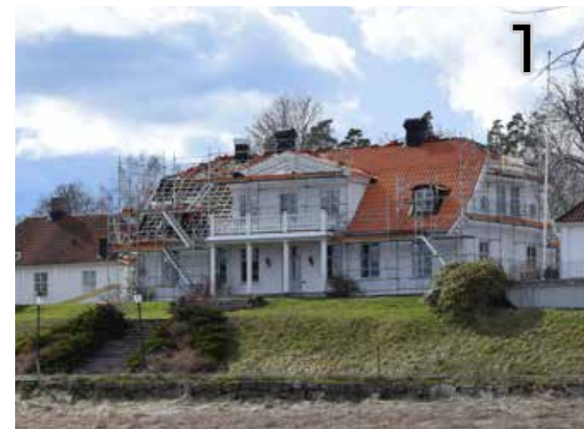
Säteriets huvudbyggnad, östra fasaden.
