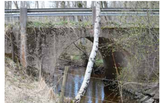
Betongkulvert över Brunnsbäcken. Plakat med texten "Vägen till Åsakullen byggdes år 1946" uppsatt på dess östra sida.
