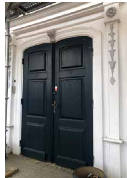
Entré mot väst med portal dekorerad med girland.
