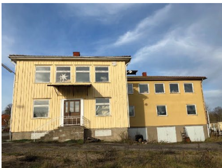
Bild på den tidigare sömnadsfabriken där man ser originalbyggnaden från 1939 till vänster och tillbyggnaden från 1961 till höger.
