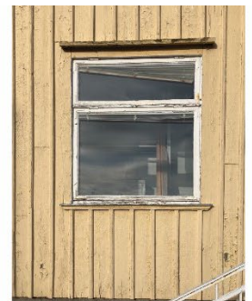
Bild på fönstersättning och fönsterutformning på den tidigare sömnadsfabriken.
