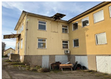
Bild på den tidigare sömnadsfabriken där man ser att grund och trappor upp till ingångarna är i betong.
